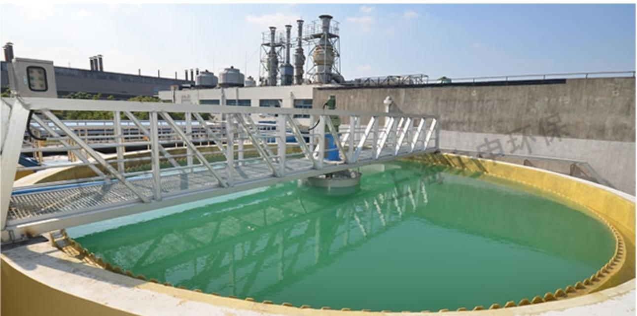
中心传动刮吸泥机运转管理。沉淀池内积泥不宜过久全桥式刮泥机，超过2天后泥质就相当密实。吸泥时，须注意排泥的情况。如发现阻塞现象，即须停车，待排泥管疏通后再行进。超过4天以后，泥质已积实，须停清洗池底后才能使用吸泥机，否则不但无法吸泥半桥式刮泥机，且泥的阻力会使机架变形和设备受损。若池内水面结冰，应在解冻或破冰后才能使用。防止池内掉入砖头等硬质杂物，保持池底平滑，以免阻挡吸泥嘴，发生损毁吸泥嘴现象。
