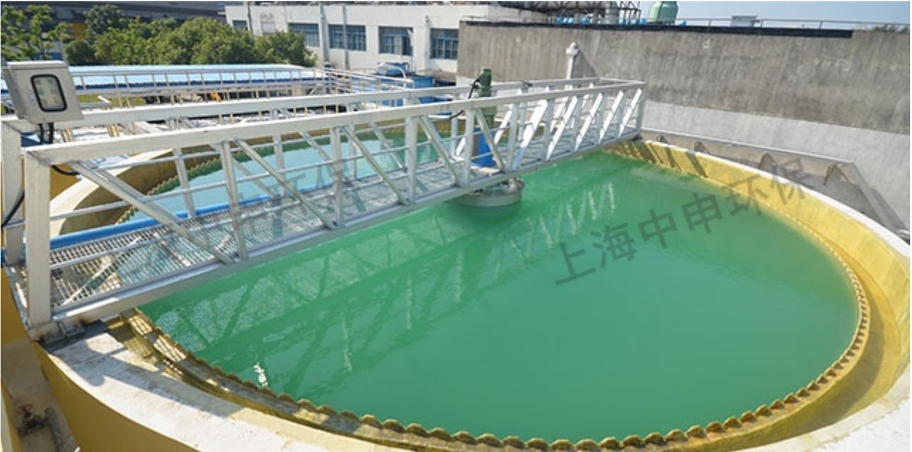
中心传动悬挂式刮泥（浓缩）机：中心传动悬挂式刮泥机、浓缩机是城市水厂、城镇污水处理厂常用的沉淀池刮泥设备，刮泥机一般用于初沉池和二沉池中，泥水分离沉淀后在沉淀池池底会形成一层污泥，刮泥机的主要作用是将沉淀下的污泥刮至泥斗。刮泥机按照工作形式的不同可以分为周边传动式、中心传动式和行车式这三种类型，中心传动刮泥（浓缩）机，主要可以分为两大类：中心传动悬挂式刮泥（浓缩）机和中心传动垂架式刮泥（浓缩）机。
