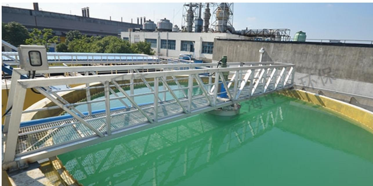
中心悬挂式刮泥机作为污水处理厂重要的污泥处理设备，以其较强的处理能力和良好的处理效果而受到许多污水处理厂的青睐。中心悬挂式刮泥机被广泛应用于大型供水厂或污水处理厂的矩形沉淀池中。中心悬挂式刮泥机是一种污泥处理装置，它将污泥从出水口区域刮到进水口区域，然后将污泥刮入进水区的集泥坑，在步行和抽水过程中逆转传统的人工虹吸挖泥船。中心悬挂式刮泥机与传统的链式铲运机、桁架式刮泥机等设备的不同之处在于，刮泥板完全沉在池底，不会受池内空间大小的影响，特别适用于斜管卧式沉淀池刮泥和填料刮泥。中心悬挂式刮泥机不受池体长度和深度的限制，池体长度越长，设备的经济效益越大。许多生产企业都会安装和使用中心悬挂式刮泥机来完成污水处理工作，因为刮泥机的结构简单，安装方法快捷方便，在污水处理设备的使用中也可以达到理想的应用目的，因此在污水处理行业中，刮泥机的应用受到高度重视。绍兴刮泥机厂家价格刮泥机设备价位。认准上海中申环境工程有限公司！
